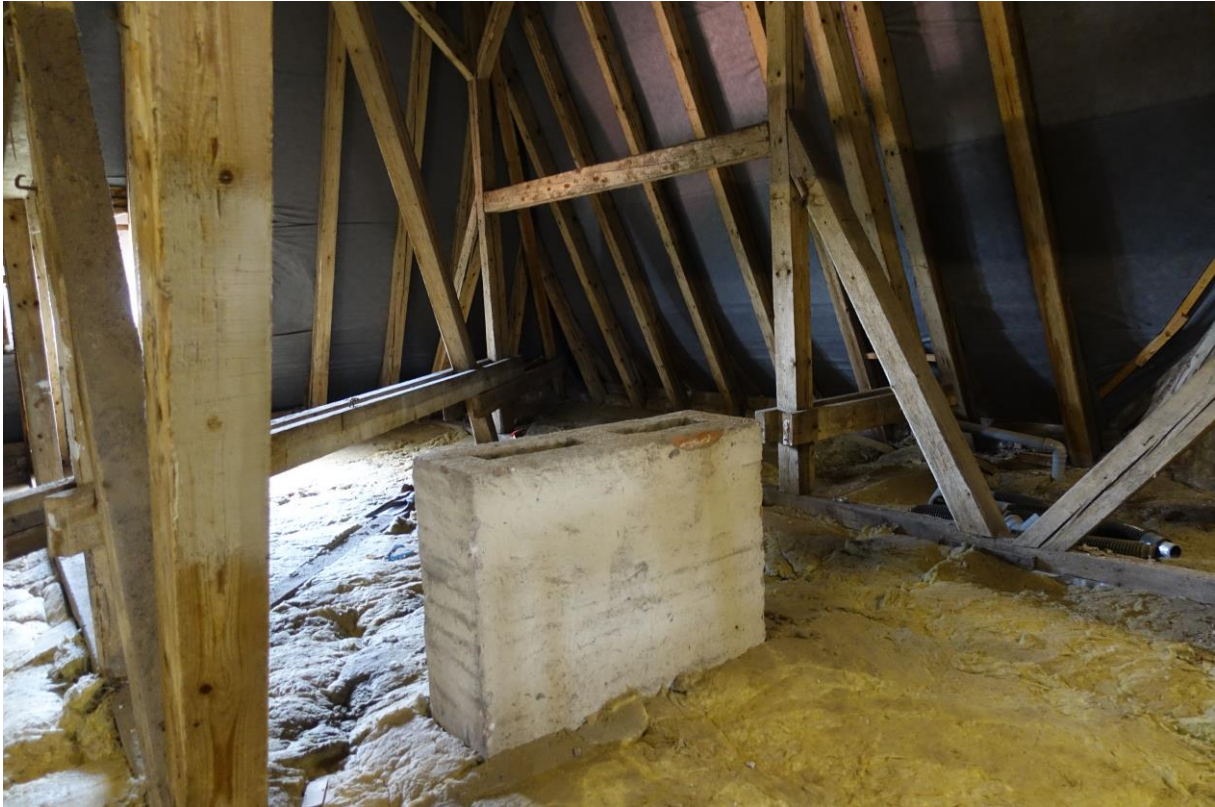
Abbildung 70 Lüftungskanäle auf dem Dachboden
