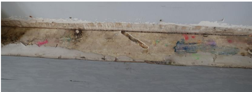
Abbildung 6 Offener Fußbodenbelag mit sichtbarem Fußbodenaltbestand (Quelle: LAV)
